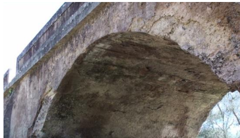
onder een andere brug zagen wij het nest van een
