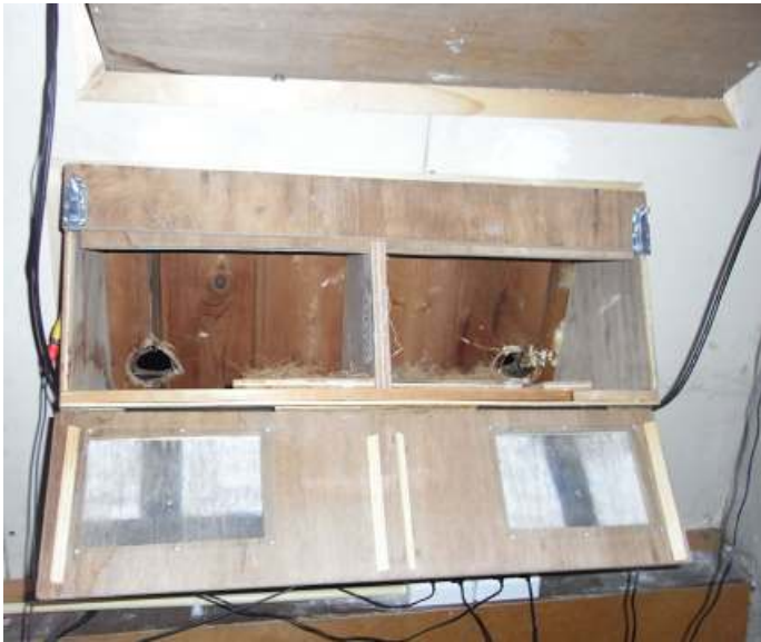
© Foto 2: Gierzwaluwkasten achter het dakbeschot (foto: Jaap Schröder).
